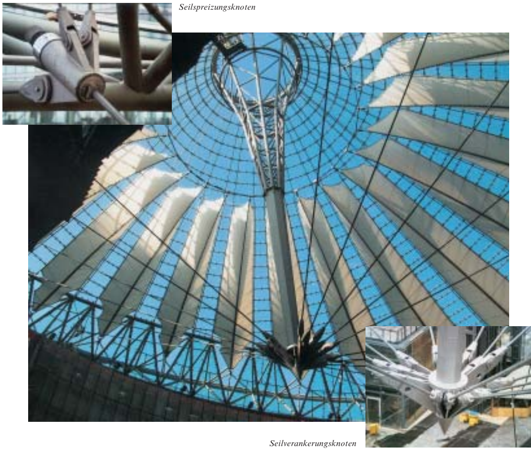
Bild 15: Dachkonstruktion des Sony-Center in Berlin, mit Laschen für den Ringbalken, die Seilspreizung- und Seilverankerungsknoten aus DILLIMAX 690 (Bild mit freundlicher Genehmigung von Waagner-Biró AG, Wien)
